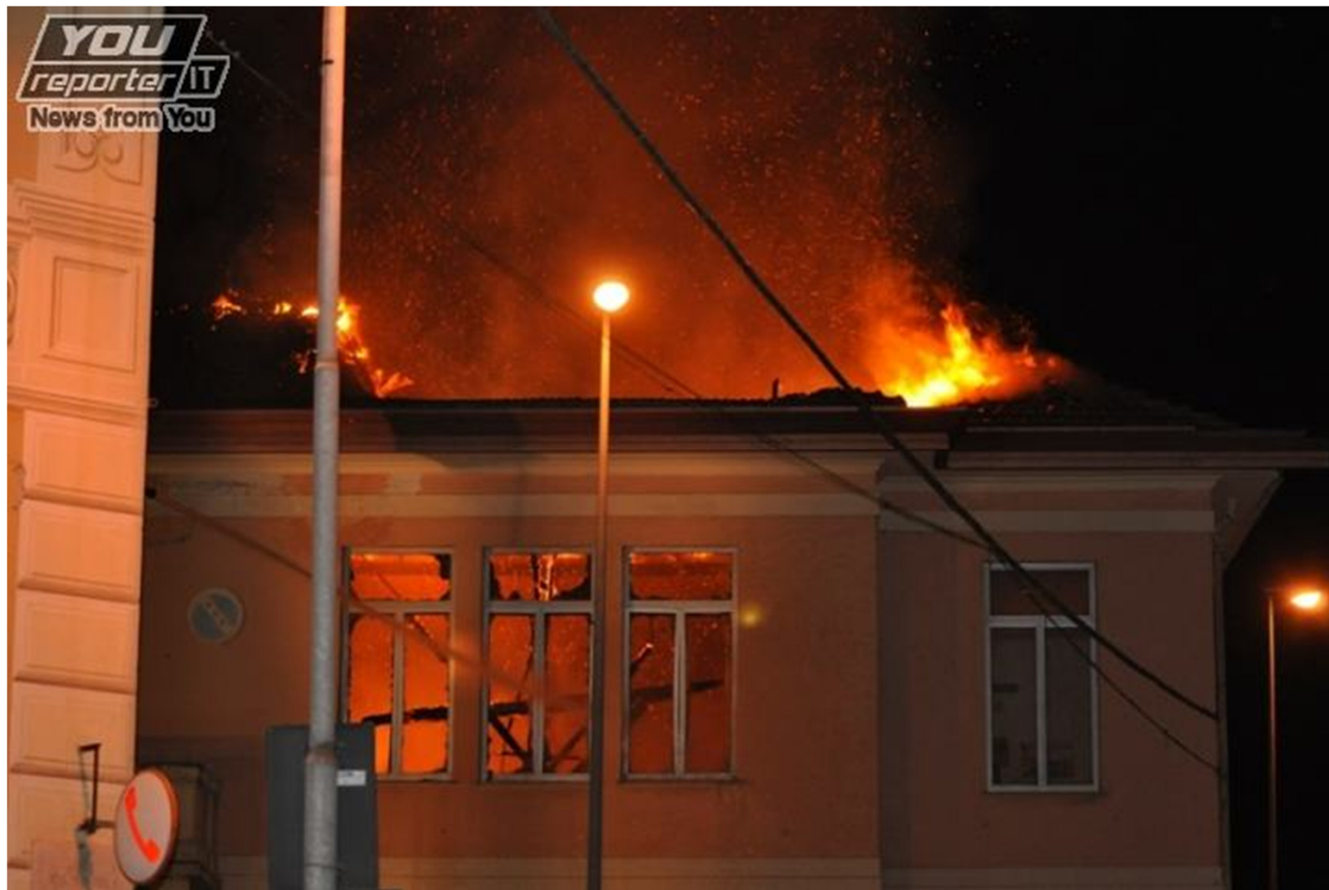
Genova – 25/11/2012 – Scuola SORI Incendio nel cantiere della scuola in ristrutturazione
