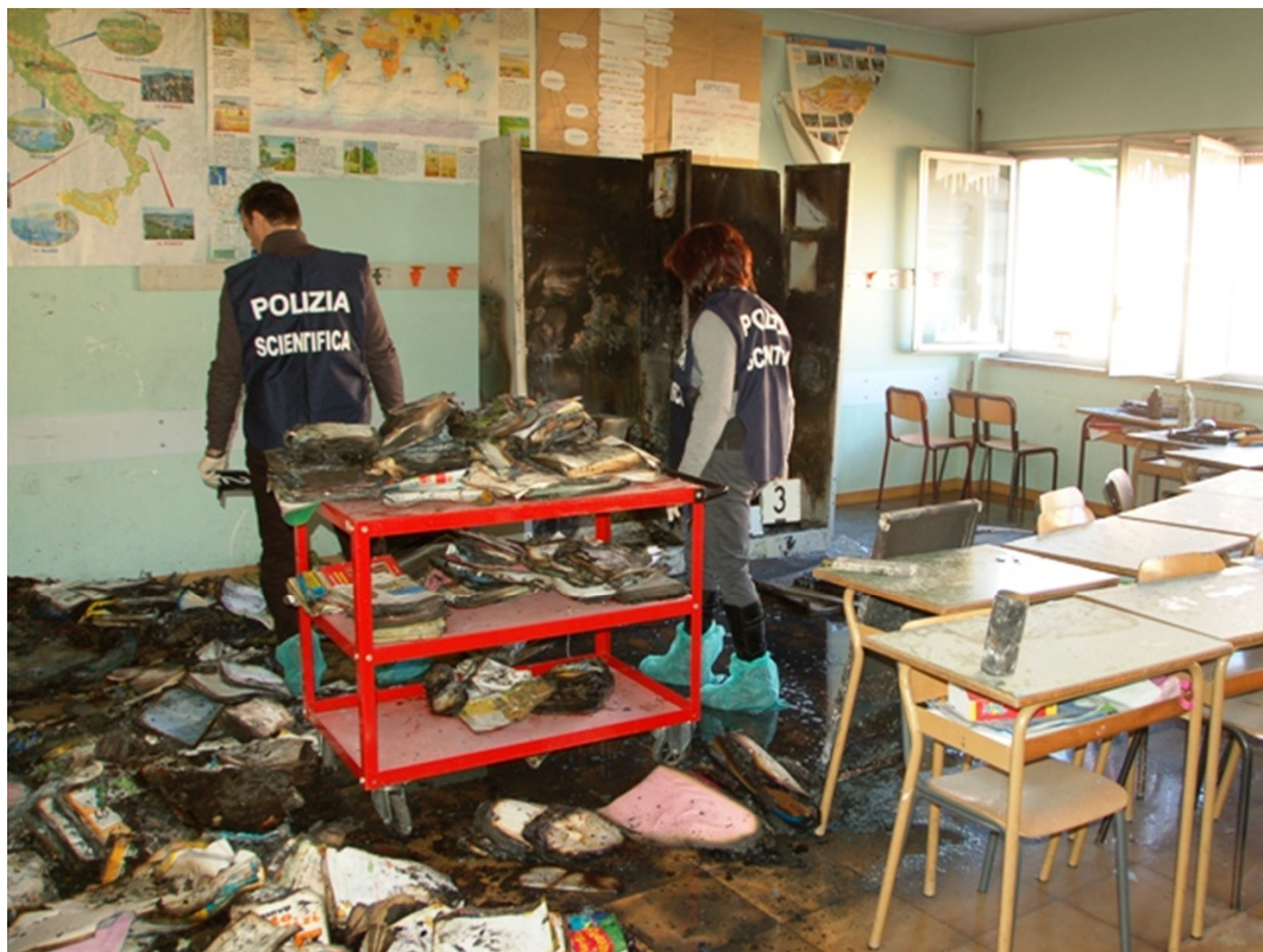
Tivoli (RO) – 11/03/2011 – Scuola Elementare ed Asilo Incendio di armadietto in classe
