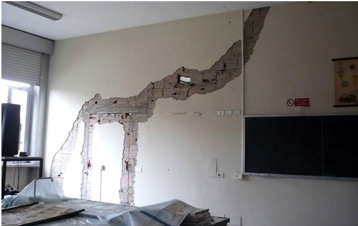
Modena – 20/05/2012 – Edificio scolastico di recente realizzazione Sisma
