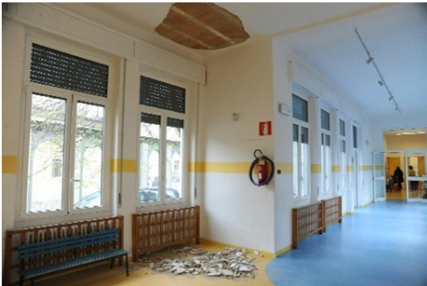
Pavia – Marzo 2011 – Scuola Materna GAZZANIGA Crollo di un metro quadrato di intonaco dal soffitto – feriti 2 bimbi
